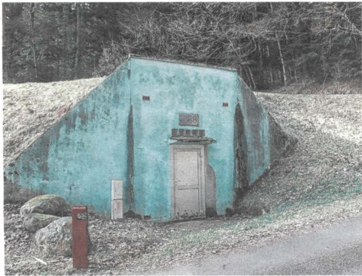
Le réservoir des Hauts Prés, l'un des deux captages propriétés de la commune. Photo Alain Fendeler
